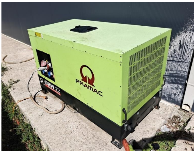
11. Agregat Pramac GBW 22 zatvoreni (2,2 KVA/16KW)
